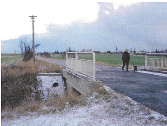
Před realizací stavby chodníku
